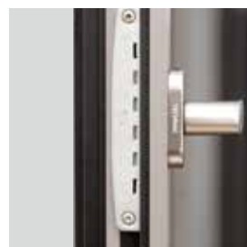
Manœuvre des fermetures par boîtier crémona bidirectionnel
